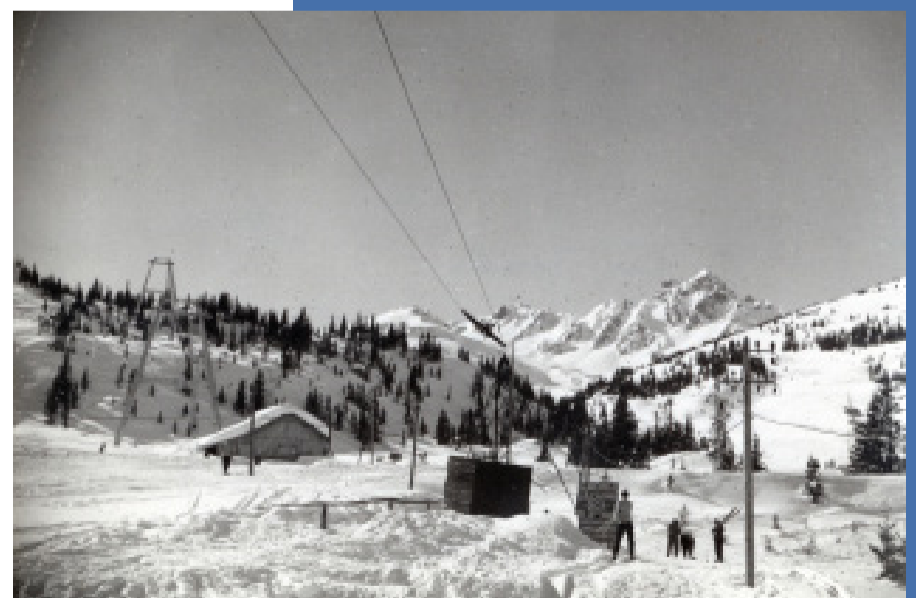
Arrivée du télési de Courchevel 1550 Les pylones du catérail – 1949 env.
