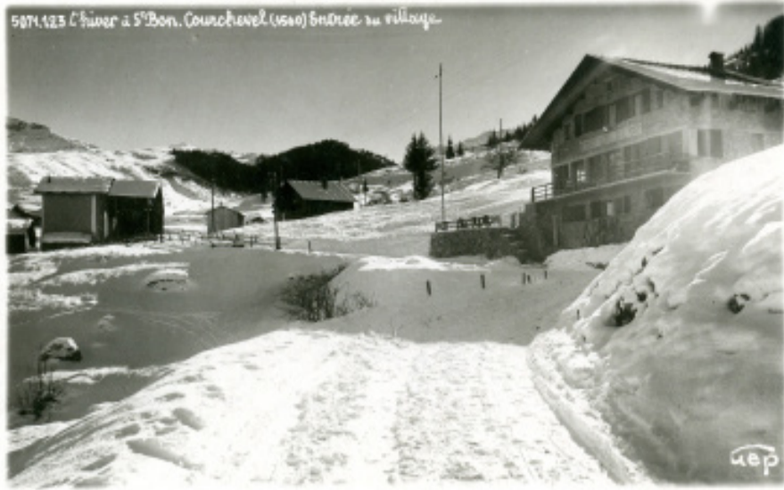
« Le Roc Merlet » (puis « Le Renouveau » et « Le Carré Blanc ») 1936
