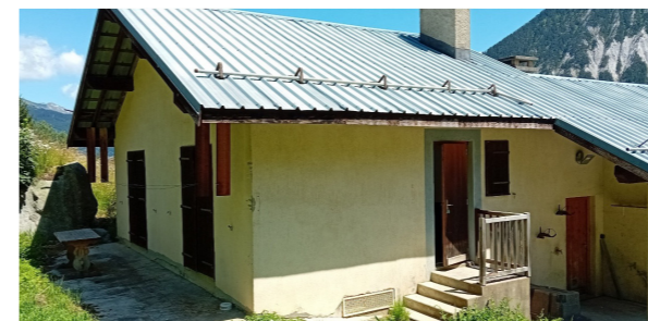
ENTRÉE DU LOGEMENT À LA FROMAGERIE
