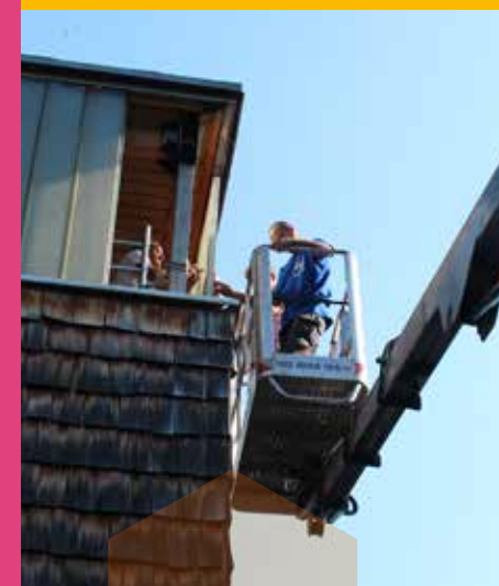
Travaux de remplacement du vitrage du gymnase du Praz
