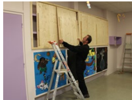
Installation des nouveaux placards dans une classe du groupe scolaire du Praz
